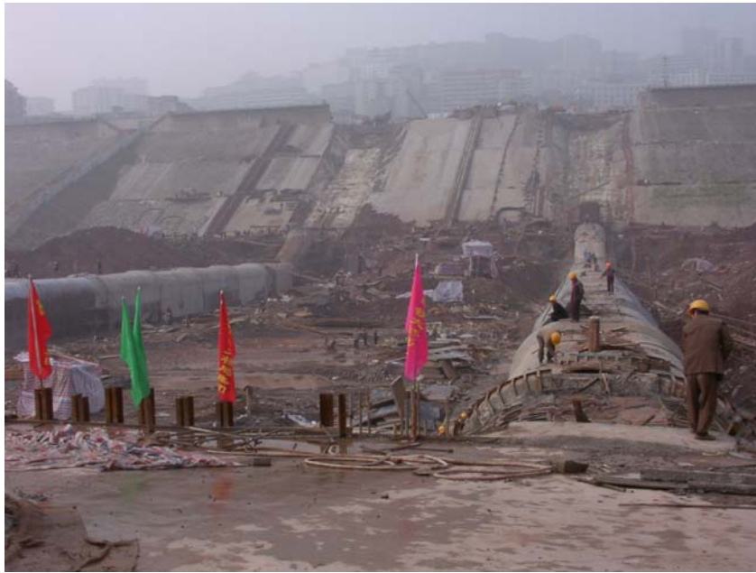
图39 斜坡交通廊道施工情况（3）
