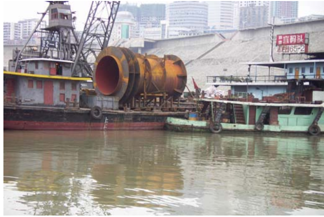
图28 预埋管接头运输情况
