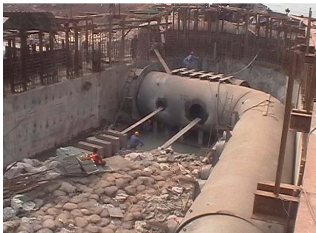
图47参观廊道安装在保护壳腔体内（III）
