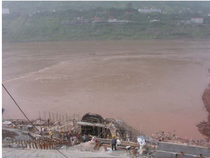
图37 斜坡交通廊道施工情况（1）
