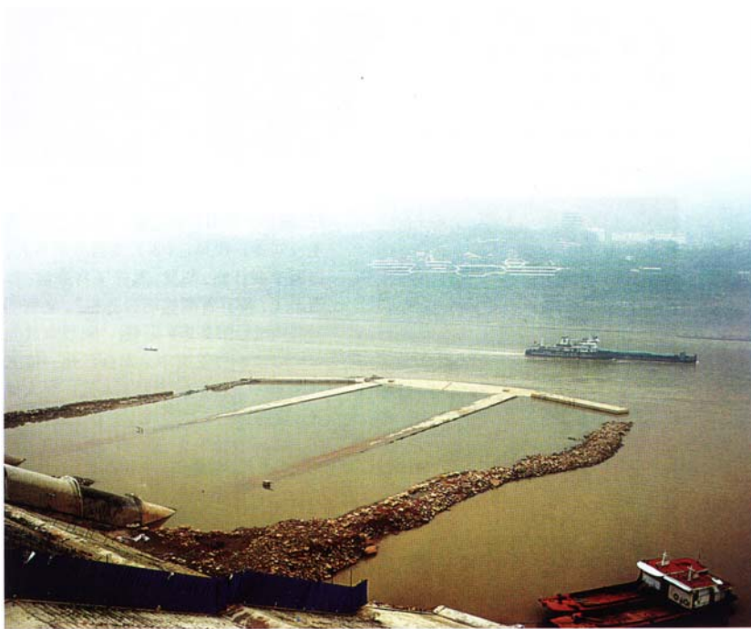
图51 水下保护工程主体部分完成后又将被长江水淹没时的情景
