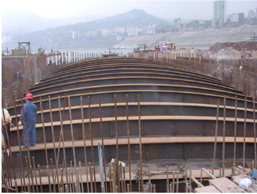
图48 穹顶钢骨架
