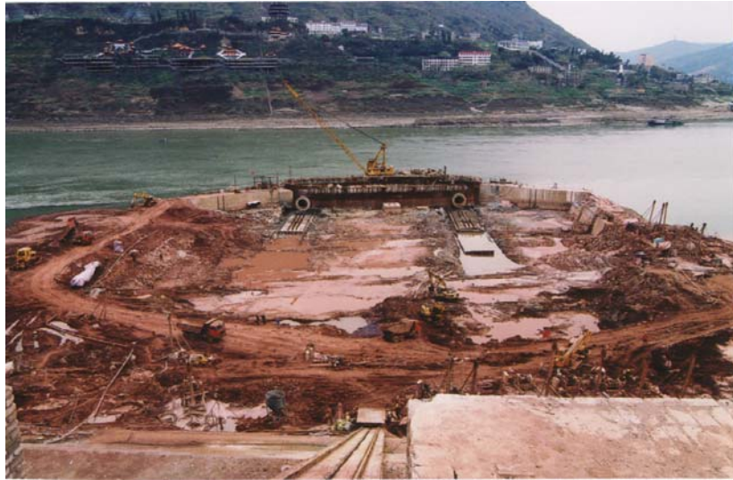
图32 合拢后的施工现场
