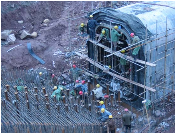
图38 斜坡交通廊道施工情况（2）
