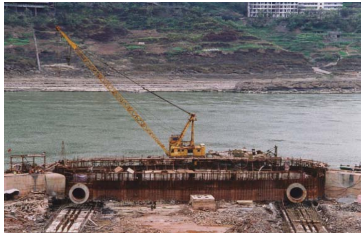
图29 保护体导墙完工后的状态
