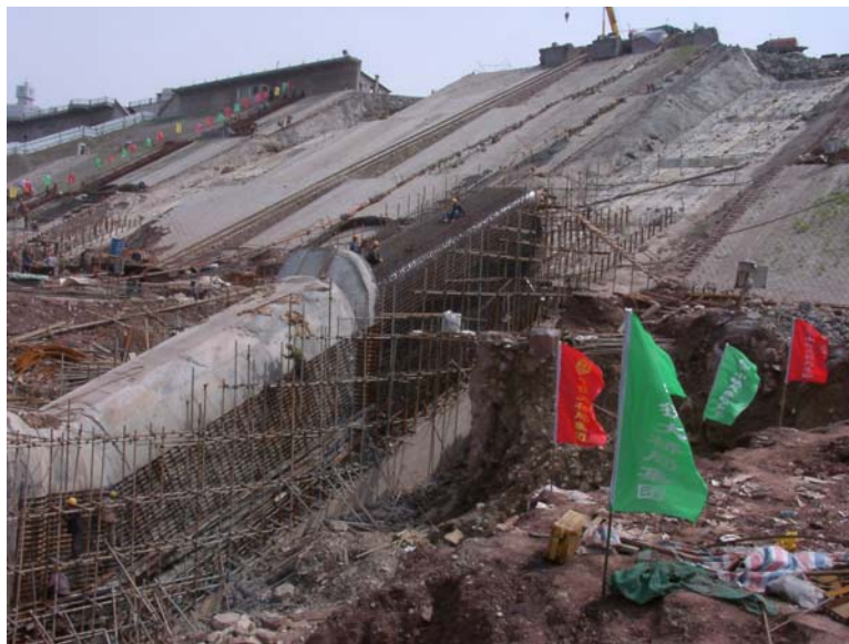
图40 斜坡交通廊道施工情况（4）
