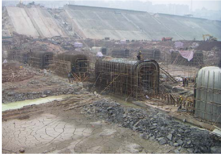
图35 上下游水平交通廊道的施工情况（3）
