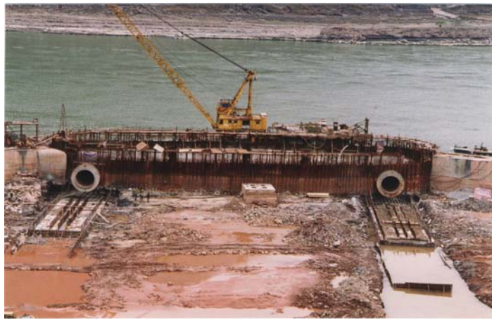
图33 上下游水平交通廊道的施工情况（1）
