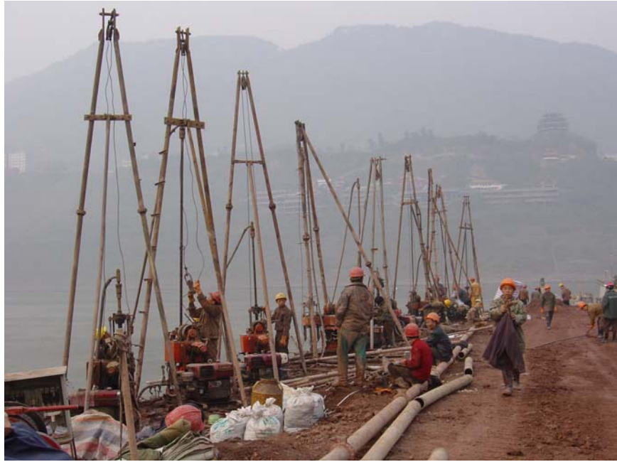
图30 围堰施工时的情况
