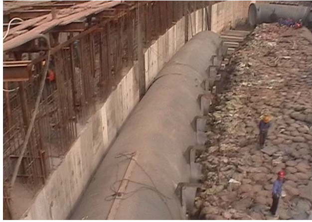
图45 参观廊道安装在保护壳腔体内（I）
