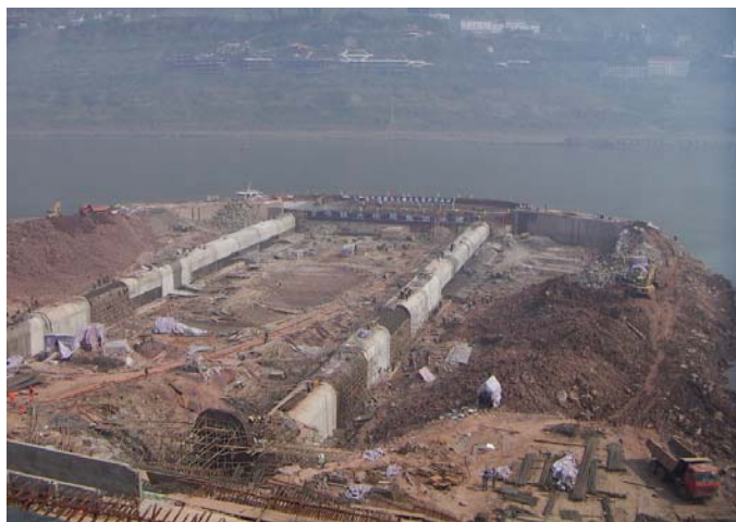
图34 上下游水平交通廊道的施工情况（2）
