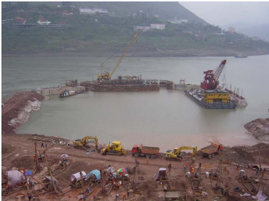
图31 围堰快接近完成时的情况
