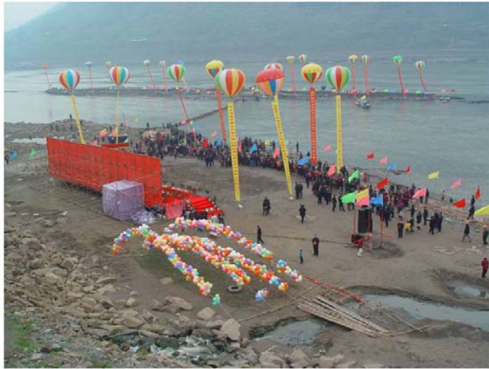
图22 白鹤梁水下保护工程开工
