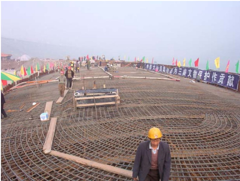
图49 浇筑钢筋砼穹顶的钢筋网
