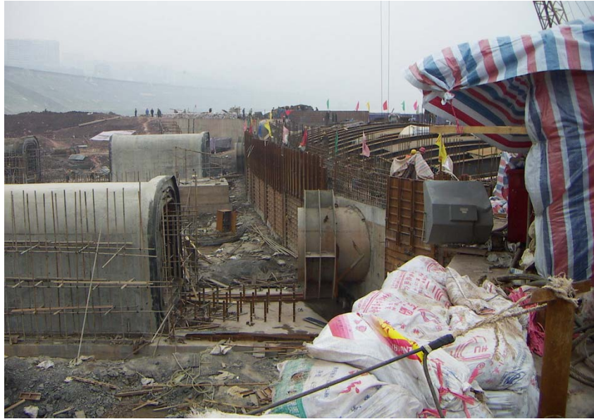
图36 上下游水平交通廊道的施工情况（4）
